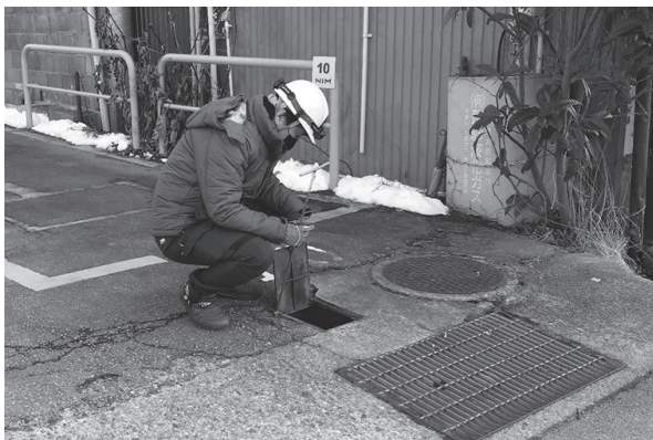
給水管の漏水調査
