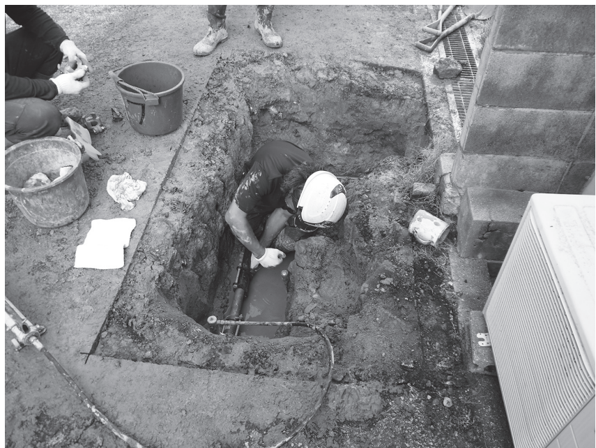
水道管の修繕
